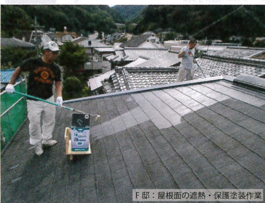
F 邸：屋根面の遮熱・保護塗装作業
