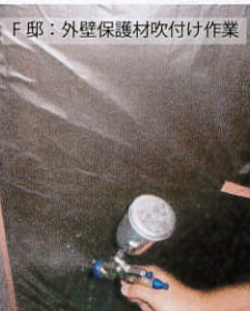
F 邸：外壁保護材吹付け作業
