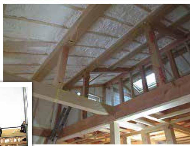
▲ウレタン吹付断熱工事が終了しました。ウレタンの断熱力は、一般的なグラスウールに比べて2倍以上です。家の隙間もしっかり埋まり、気密性能も高まります。
