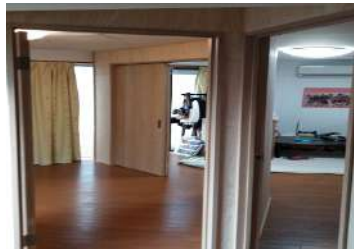
北区大將軍W様邸こども部屋間仕切工事
