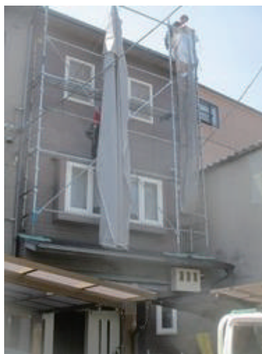
築後20年 弊社新築 メンテナンス修繕施工例 平成30年5月 Y様邸
