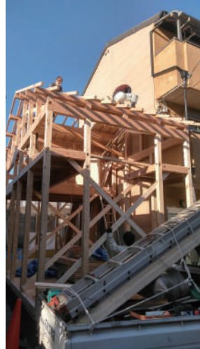
← 3月、建物の骨組みが 完成しました
