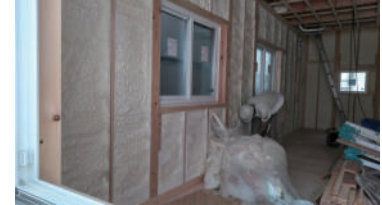
← 4月、断熱材は 高性能な吹付硬質 ウレタンフォームを 採用
