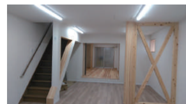
↑筋交いがスペースの間仕切りになります
