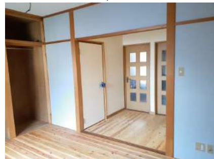
After: 雨染みがある天井は、下地の木材ごと取り去り新設しました。 洋室と廊下が一続きの明るい空間になりました。
