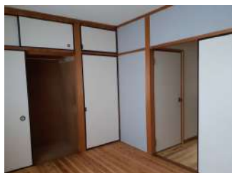
After: 収納内は、ハンガーパイプを設置して、押入からクローゼットになりました。
